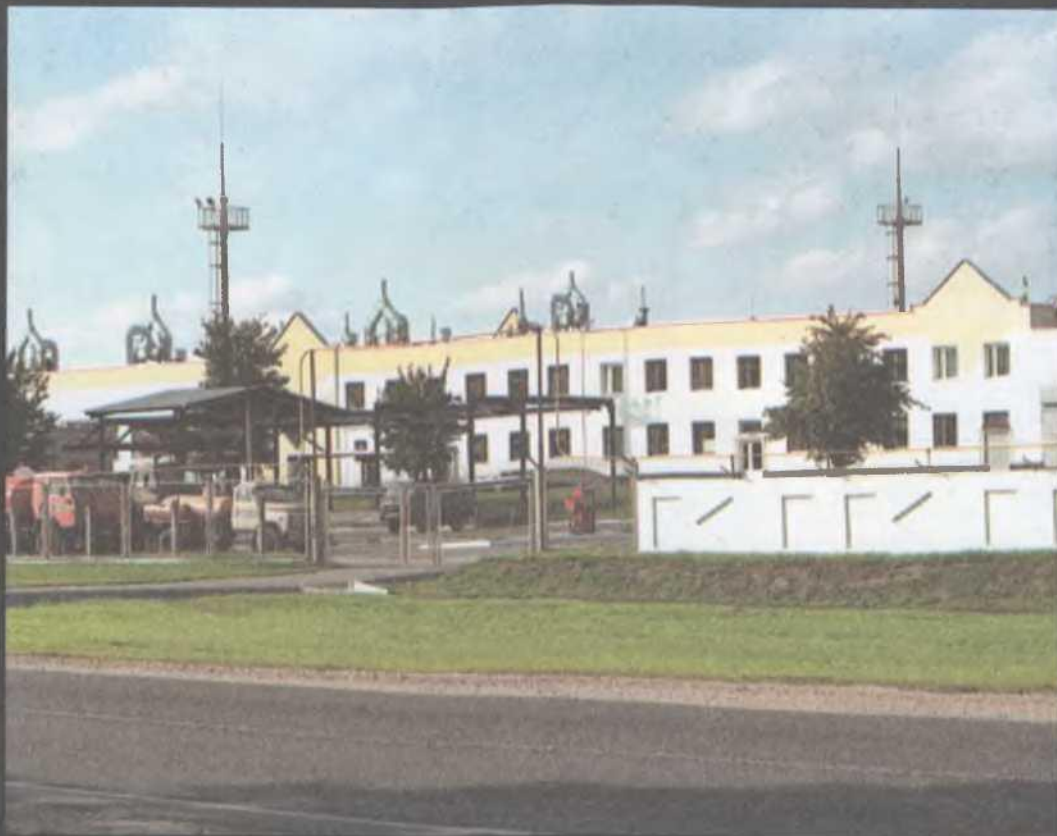
Лінейна-прамысловае ўпраўленне газаправодаў у Слоніме
